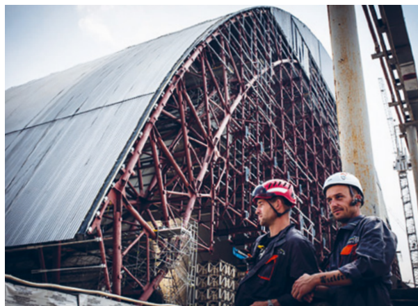
Arche de confinement du réacteur 4 de Tchernobyl installée en 2015 au-dessus du sarcophage de 1986.
