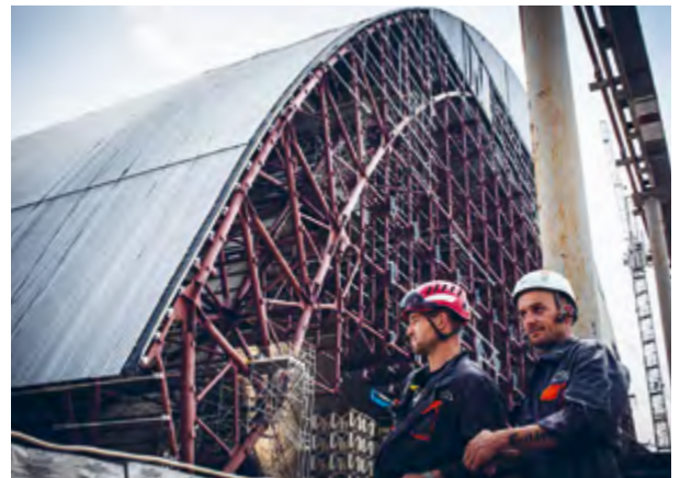
Arche de confinement du réacteur 4 de Tchernobyl installée en 2015 au-dessus du sarcophage de 1986.
